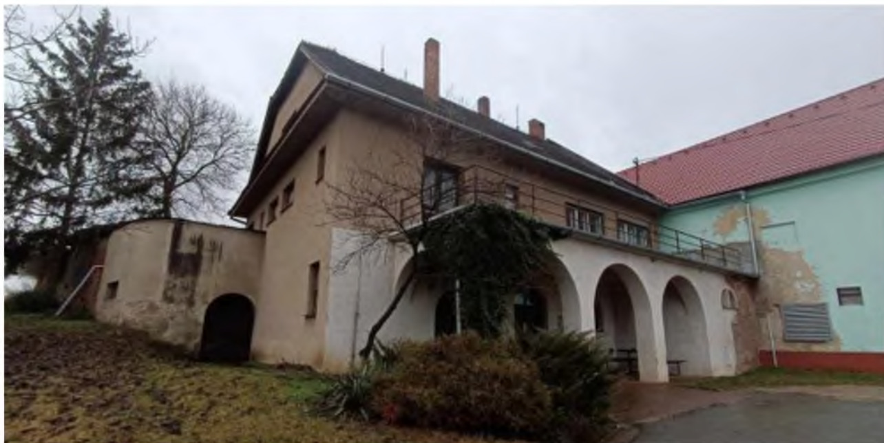
Objekt k přestavbě na ploše P.38
