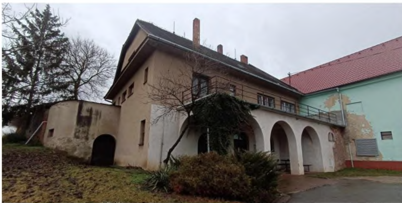
Objekt k přestavbě na ploše P.38
