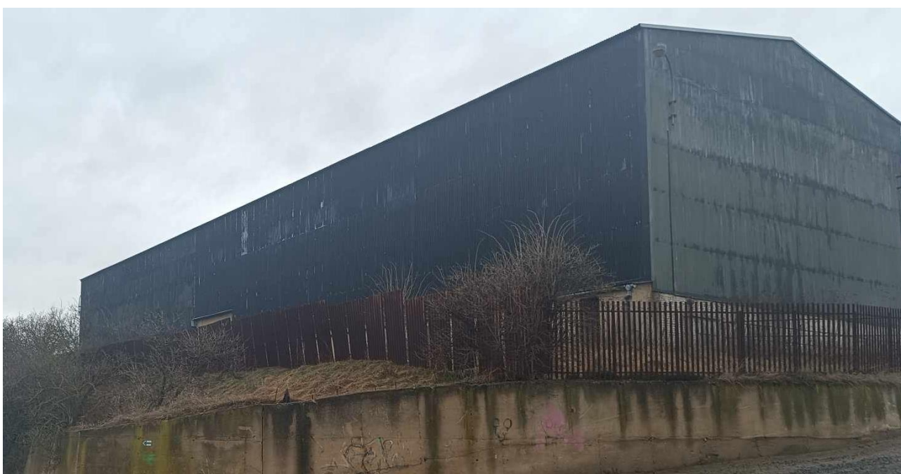
Jeden ze stávajících objektů v ploše P.7.
