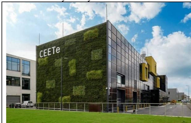
Ostrava (závěsný systém na fasádě – vertikální zahrada)
