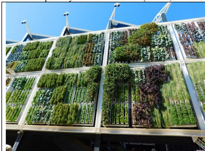
Ostrava (závěsný systém na fasádě – vertikální zahrada)
