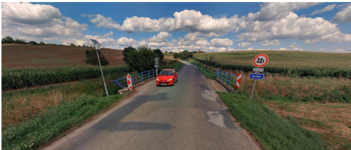
34/ Most přes říčku Malšíňku
