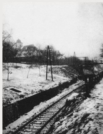
Původní jednokolejná trať v zářezu pod bohuslavickým kostelem.
