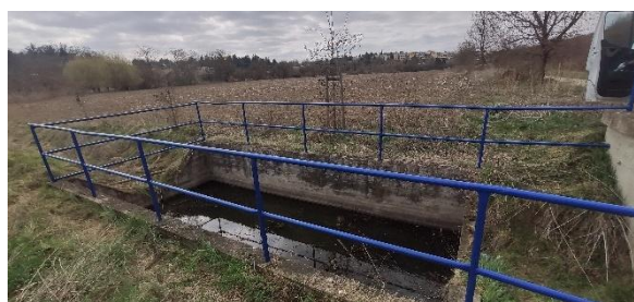
Stav po opravě
